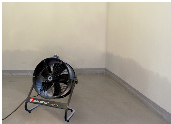
Przykład zastosowania dmuchawy do osuszania pomieszczeń
