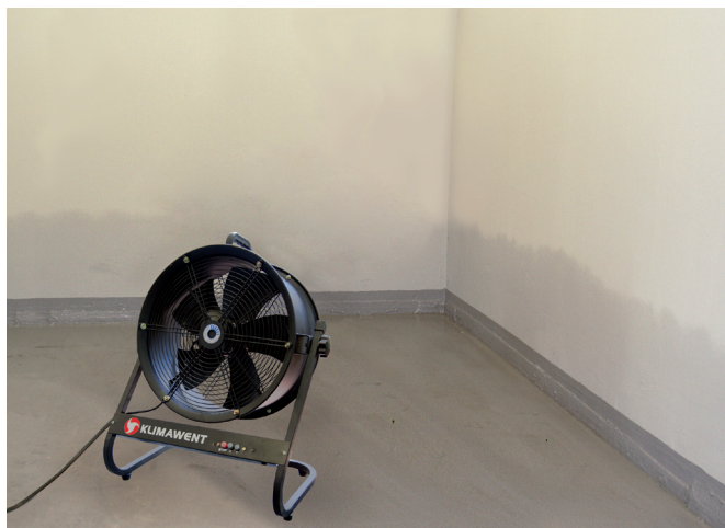
Przykład zastosowania dmuchawy do osuszania pomieszczeń
